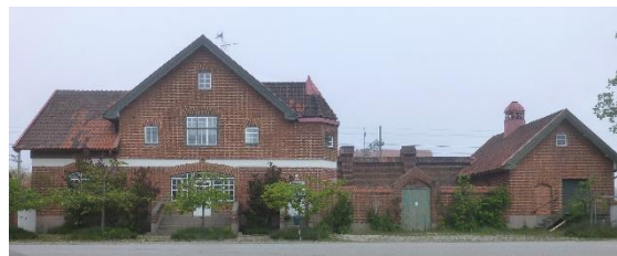
Stationsbyggnaden uppförd år 1909. Foto från 2019
