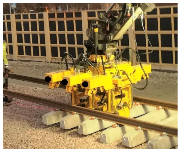
D. På varje sida finns tre klaffar under delarna som är märkta med en svart prick. Klaffarna förs ner och pressar rälsspiken över underkanten på rälsen som då låses fast mot slipparna.
