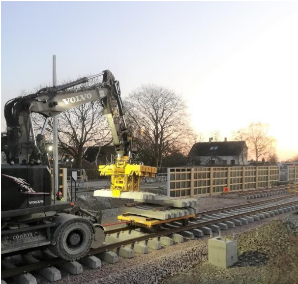
A. Ett rälsbundet fordon har en vagn efter sig med sliprar. Verktøget hämtar tre sliprar åt gången.
