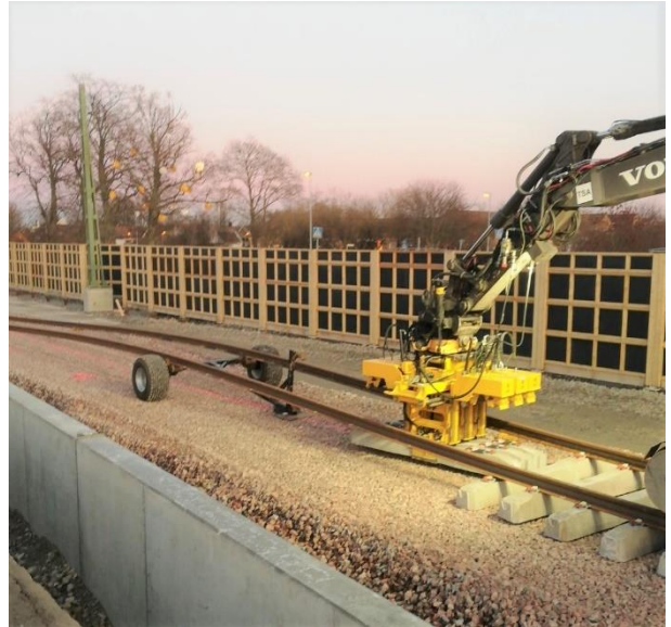
B. Hytten vrids 180 grader. Huvudet vrider slipparna så att de kommer parallellt med rälsen. Slipparna förs ner så att de kommer under rälsen som är lyft.
